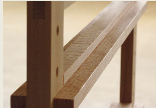
Detail: Ladenlaufleiste mit Dübel auf Rahmen
